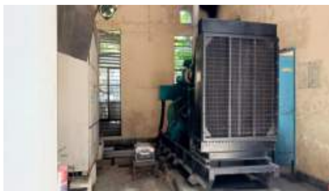
Fig : Diesel Generator (380 KVA)
