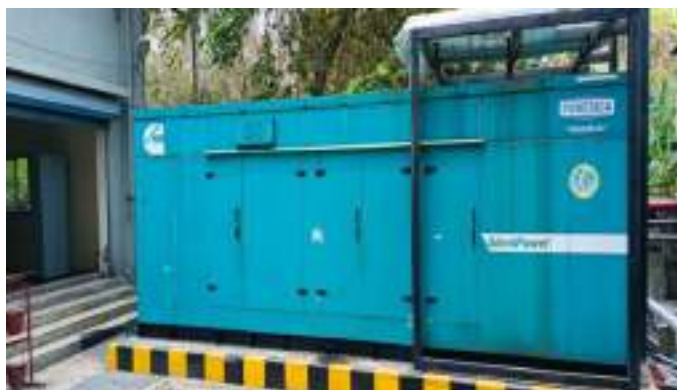
Fig : Diesel Generator (600 KVA)
