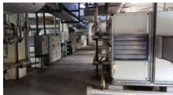
Fig : Air Handling Unit (AHU)
